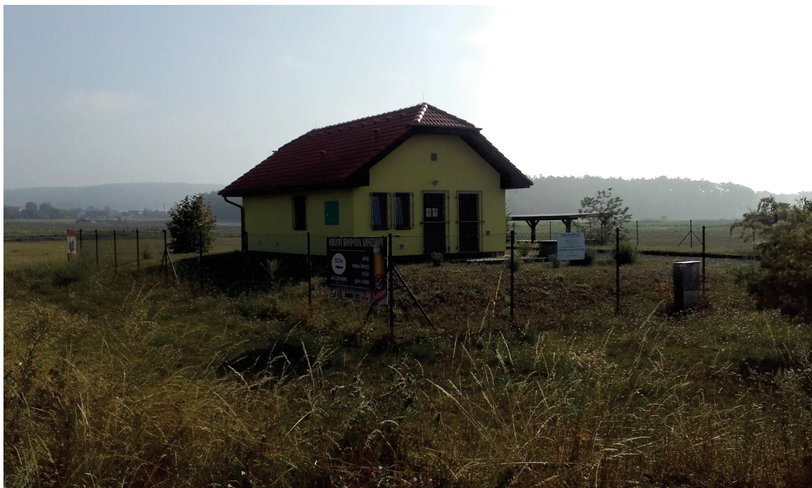
Obr. 2,3 – Foto stávající ČOV Konětopy
